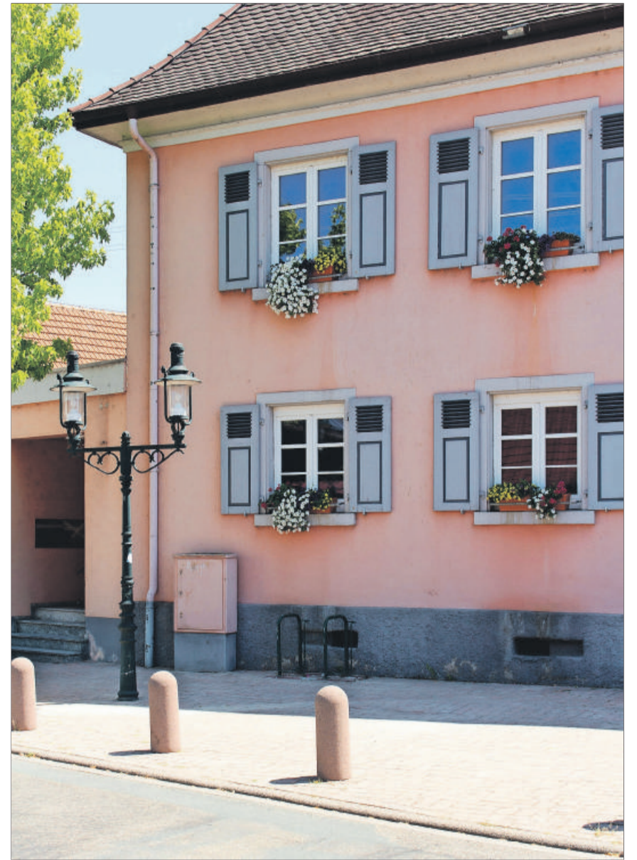
Der Stromkasten vor dem Rathaus geht in Deckung, ist aber trotzdem nicht zu übersehen, wie Jana Schmieders Foto deutlich macht.
