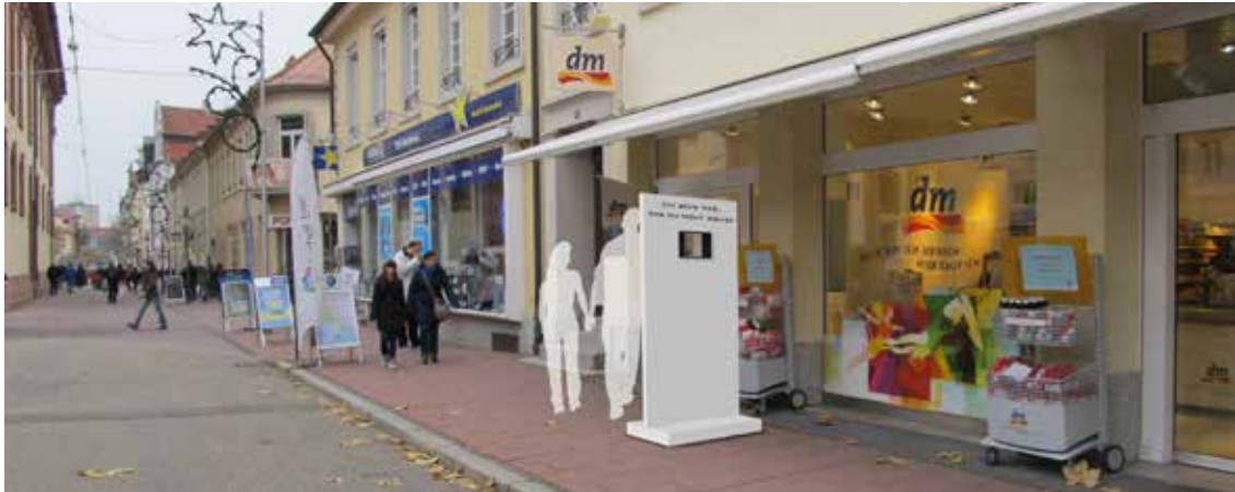
Installation des Sichtfensters in der Kaiserstr.
